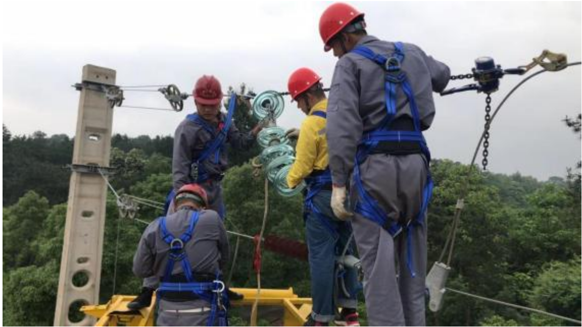
图 3：学生进行线路检修实训
