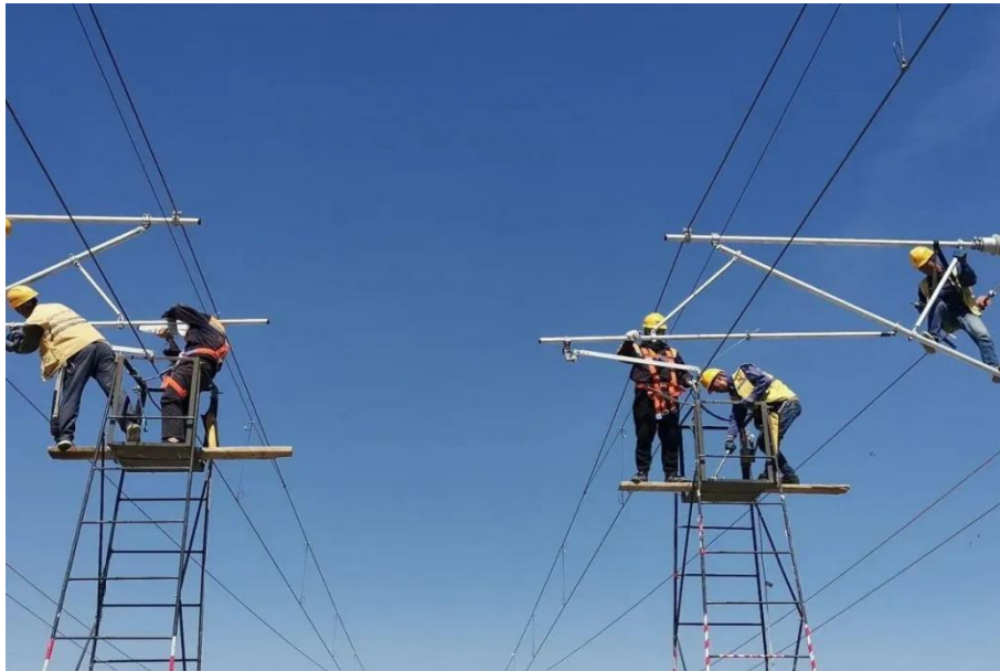
图 2 接触网检修模拟实训图
